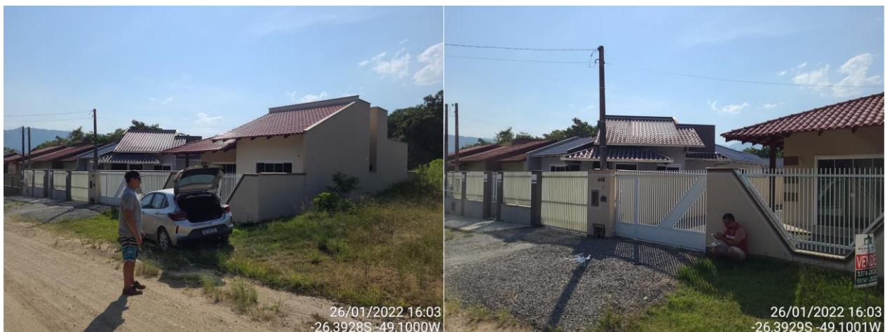
Figura 19. Casas recém-construídas ao lado do imóvel em análise. Caso a drenagem existente nos fundos destes imóveis, isto é, o canal de irrigação das plantações de arroz, fosse um curso d'água (rio), as mesmas estariam inseridas parcialmente em sua APP de 30 metros, como pode ser visto no mapa da Figura 18. Fonte: Rafael Brito Silveira, 2022.
