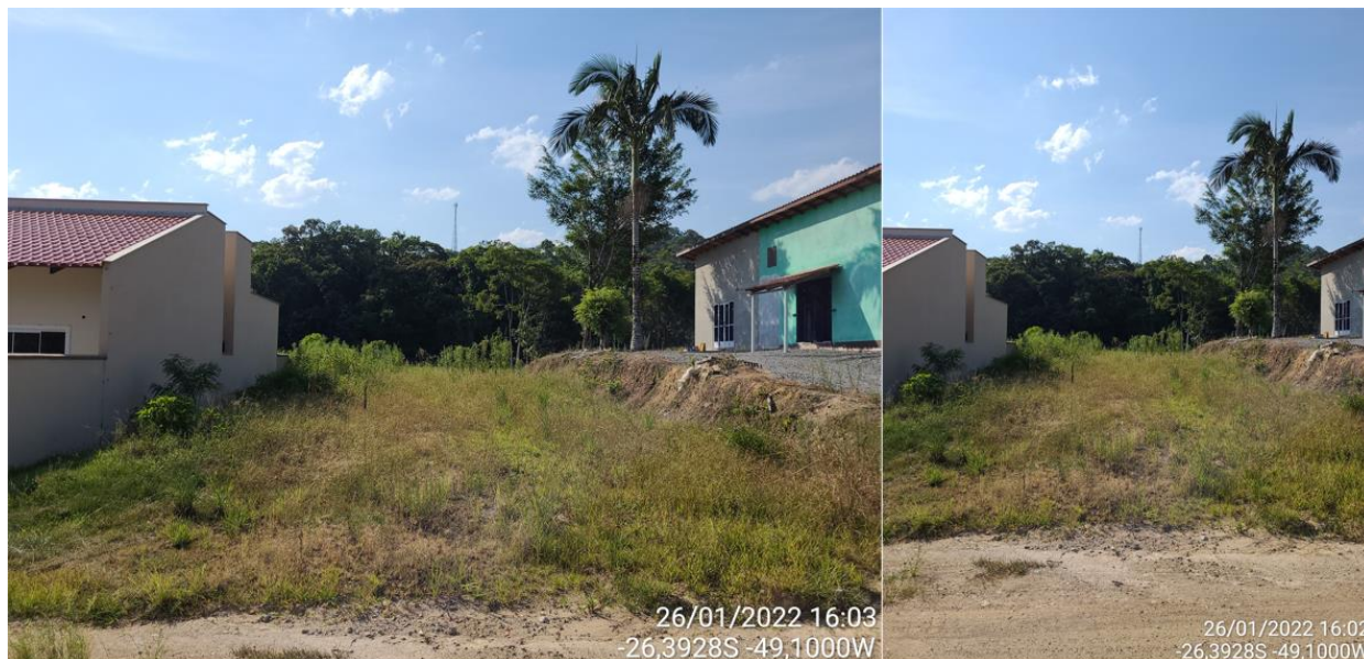
Figura 12. Fachada frontal (sudeste) do imóvel em análise. Fonte: Rafael Brito Silveira, 2022.
